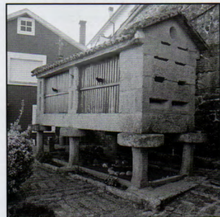
Cimentación oculta por ornamentación. Laura Casalderrey González. Casal Novo.
