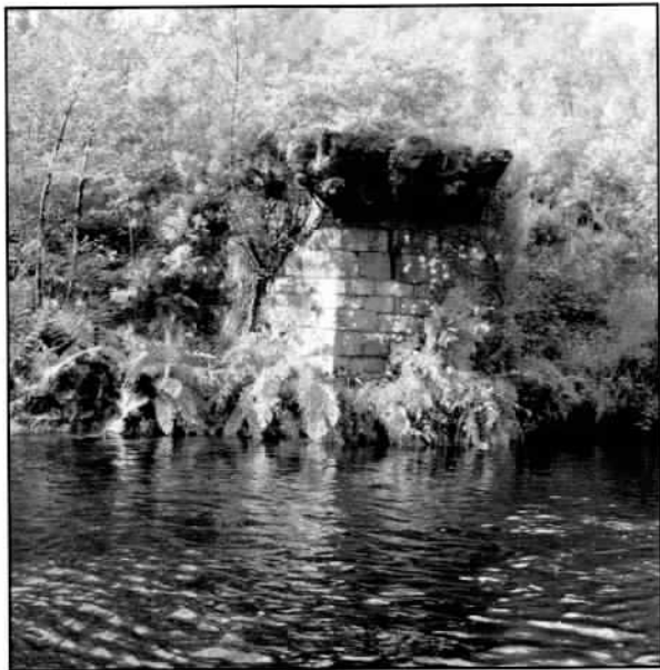
Ménsulas de apoio das traves
