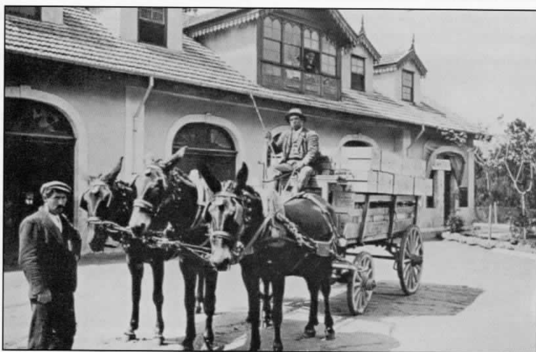
Transporte das augas, edificio administración. J. Pintos, 1908
