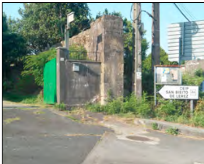
Vista actual do fin da estrutura primitiva do cano. Antigamente a partir de aquí seguía aérea ata o convento.
