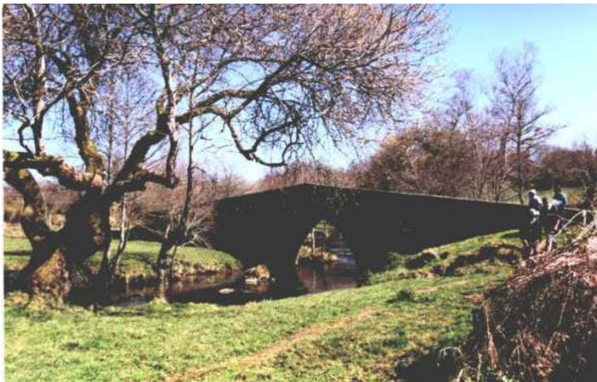
Ponte de Andón, situada no lugar do mesmo nome, na parroquia de Acibeiro. É a mellor conservada
